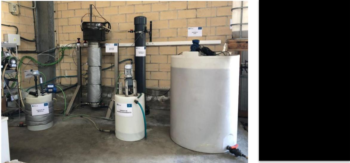
**Figure 36.** Solution technologique 100 L LIFE Multi-AD installée chez AEMA (Alfaro) et dimension réacteur anaérobie.
